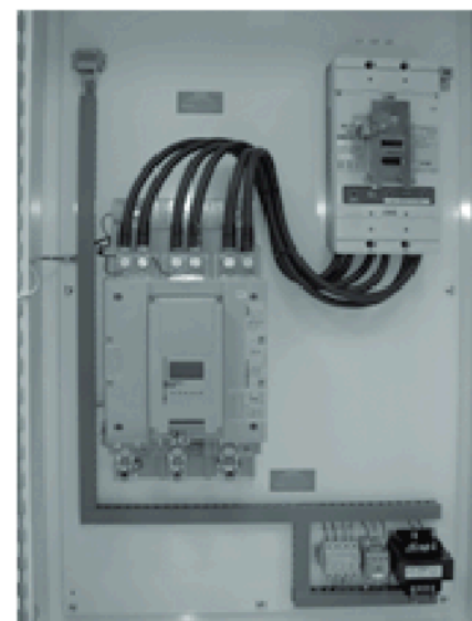
PFS Softstarter Custom MCCB Combo 400HP@480V AC
